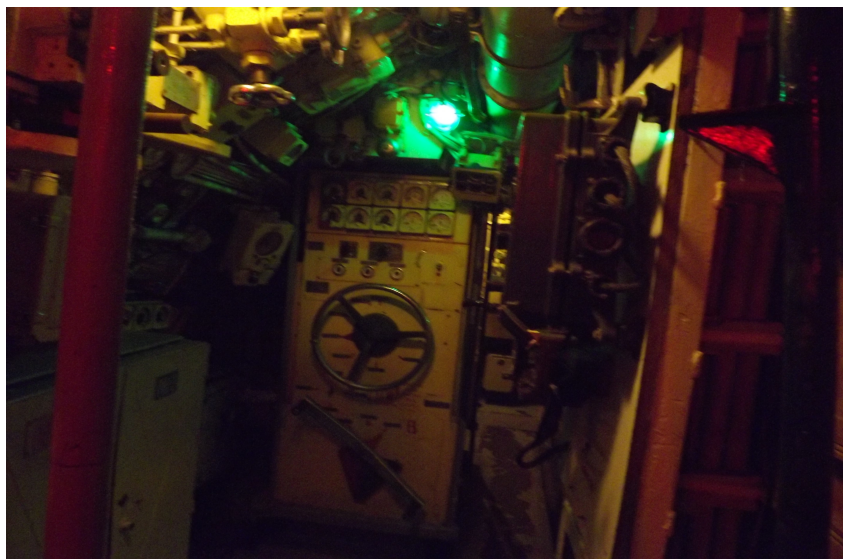
Salle des machines ©2015
